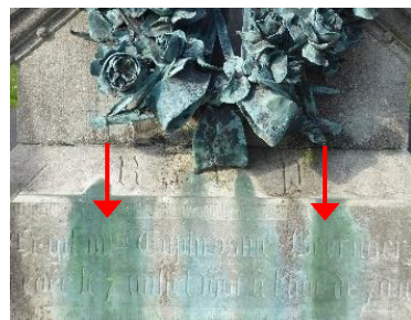
Verkleuringen op de steen
