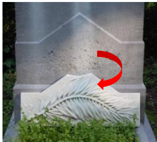
De plaat is losgekomen
