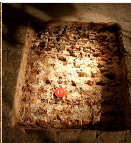
Fenêtre bouchée ©M. Vanhulst.
